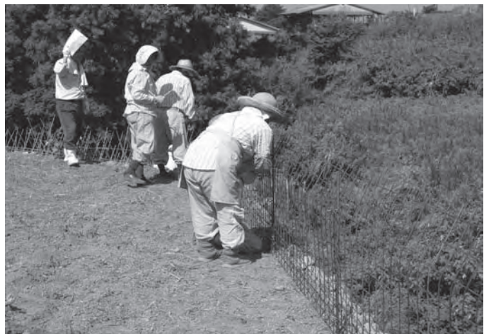
防護柵の設置
