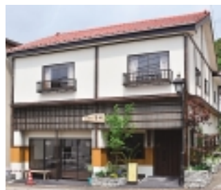
施工：中村工務店(南串山町)
